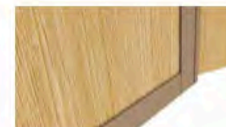
Liaison sur module fusserie avec couvre joint apparent.
